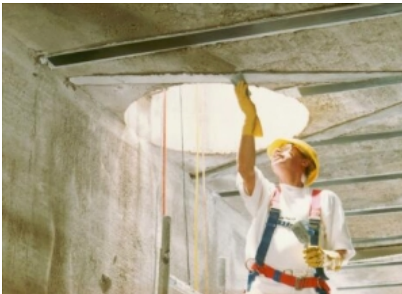
Bild 1: CFK Lamellenverstärkung im RRB Offenbach
