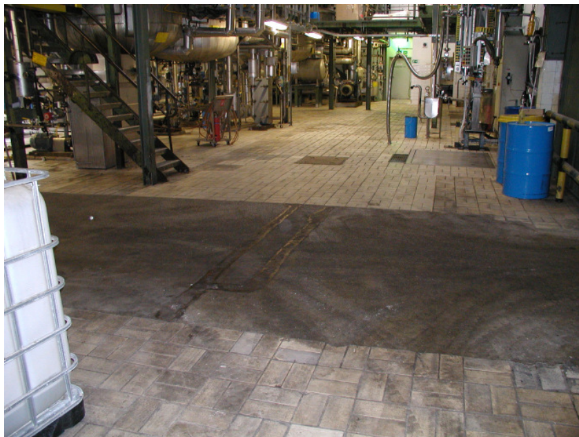
Bild 1: Bodenflächen vor der Sanierung
